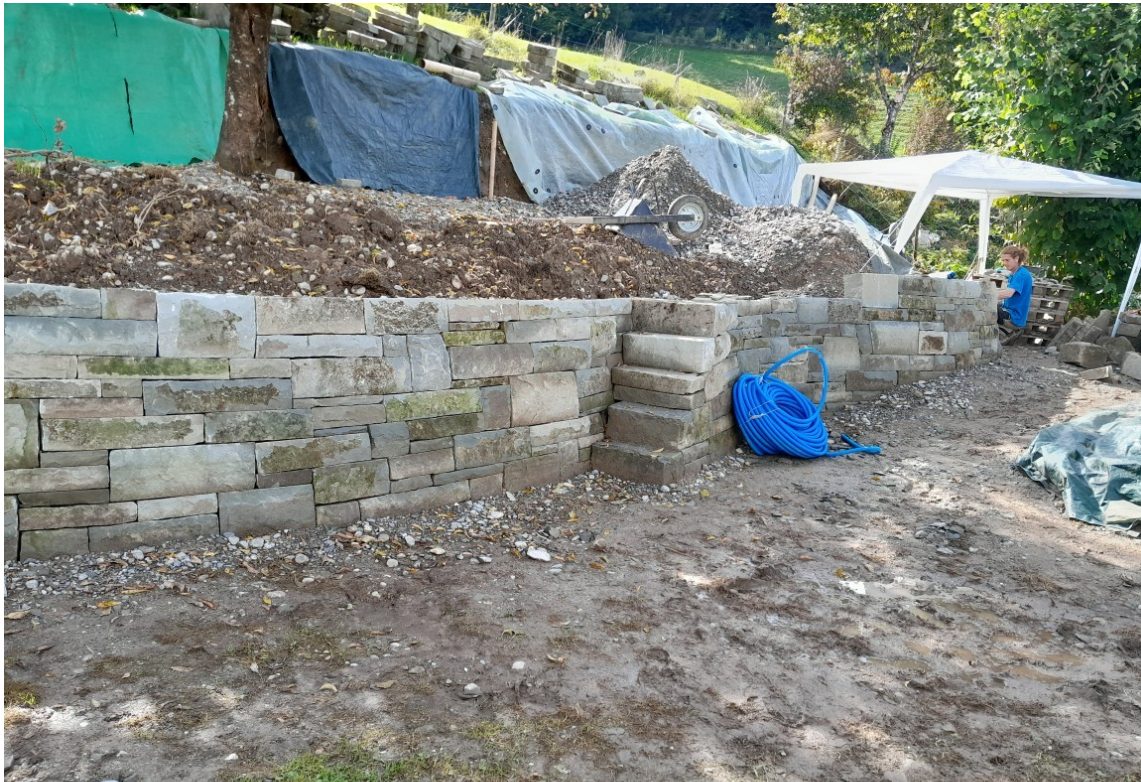
aktuelles Sanierungs- Projekt in Wald
